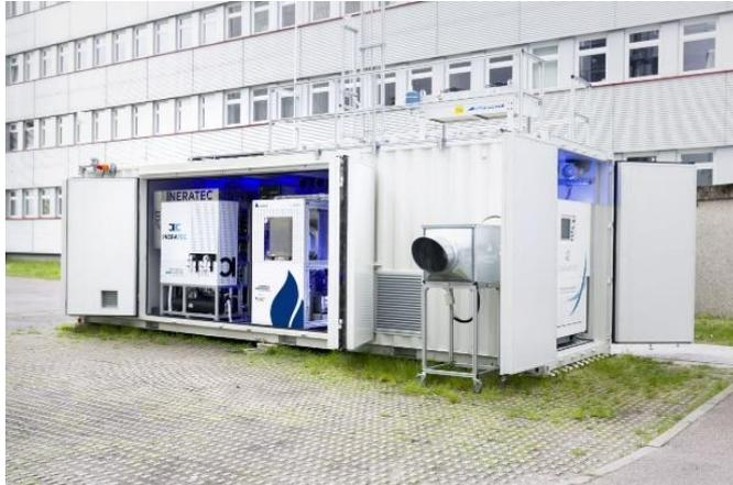
**Abbildung 10: Weltweit erste integrierte Power-to-Liquid (PtL) Versuchsanlage zur Synthese von Kraftstoffen aus dem Kohlendioxid der Luft<sup>136</sup>**
